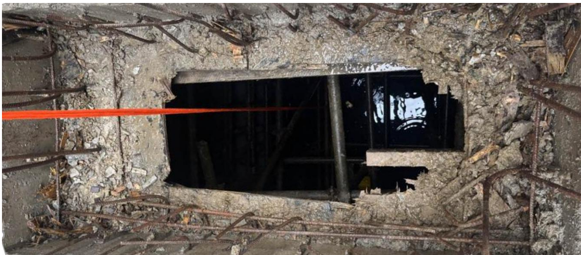
图 8 D1#楼梯第二级休息平台预留洞口、孔洞（救援破拆后）实景图
