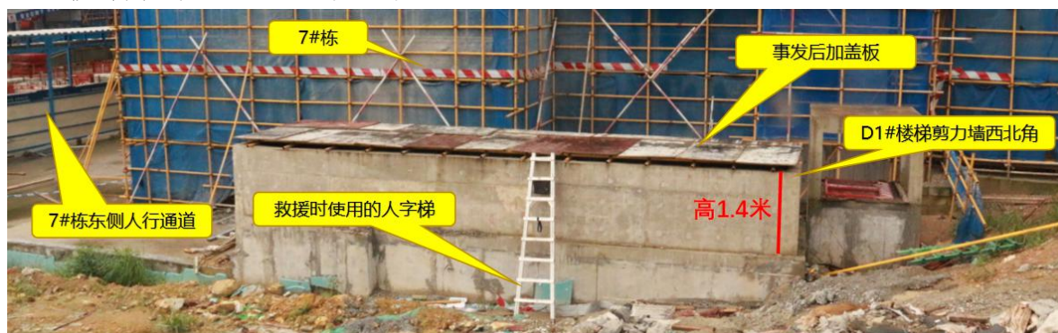
图 7 D1#楼梯剪力墙现场勘查照片
